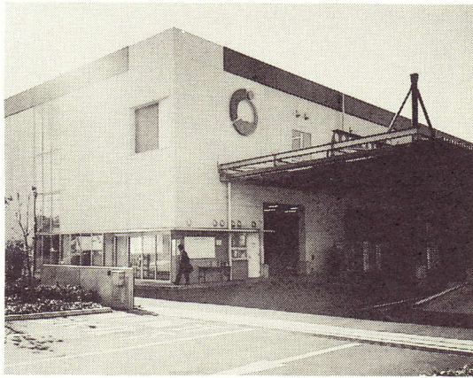
廃家電処理工場・東京エコリサイクル(株)
