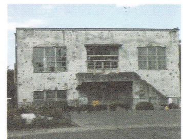
都立東大和南公園内に ある弾痕生々しい旧変電所
