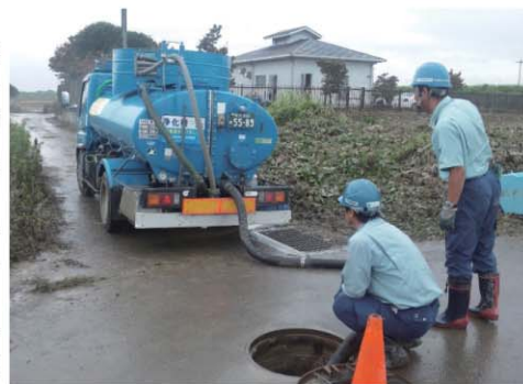
バキュームカーによる排水作業
