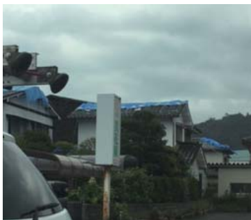
ブルーシートをかけた屋根が目立つ倉吉市内
