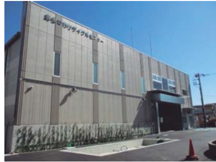
リサイクルセンター外観
