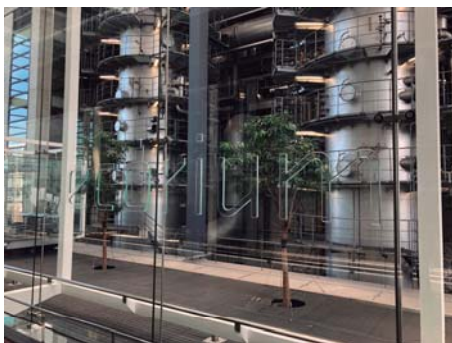
エコリウムと名付けられたガラス張り の見学通路
